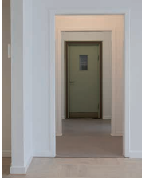
Et kig til den oprindelige elevatordør, som stadig er synlig i lejemålet på 1. sal. Fotograf Jes Larsen, Territorium.
